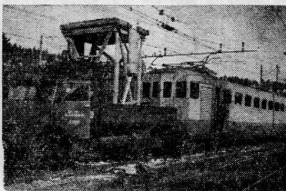
Montaža kontaktne mreže na progi Rakek–Postojna
